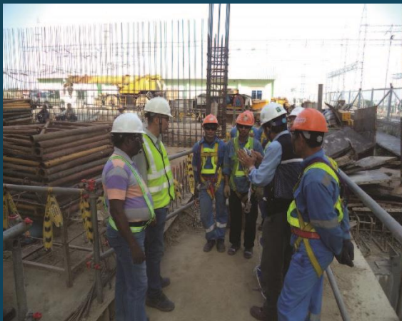
현장 시공사 안전교육
